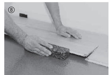
Bei Bedarf mit Schlagklotz leicht nachklopfen.
