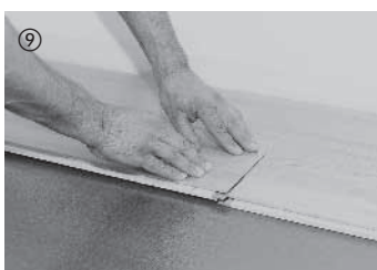
Anschließend wird das Element stirnseitig abgesenkt. Beachten Sie hierbei, dass das Element stirnseitig bündig an das zuvor verlegte Element anstößt. Durch kurzen Druck auf den Querstoß rastet das Element ein.
