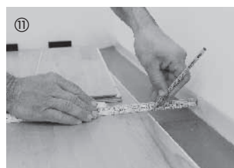
Die Elemente der letzten Reihe werden an der Längsseite unter Berücksichtigung eines Dehnungsabstandes von 10–15 mm zugeschnitten und eingepasst.
