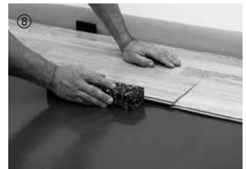
Bei Bedarf mit Schlagklotz leicht nachklopfen.
