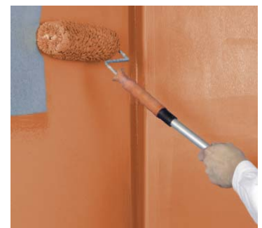
Flächiges Auftragen der FERMACELL Flüssigfolie mit Roller
